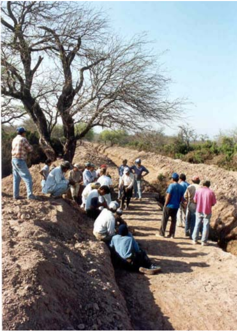
Construcción de un canal de riego vecinal, en la zona de Manga Bajada.
